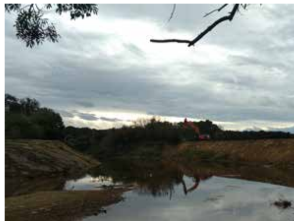
Talutage et végétalisation herbacée et arbustive à venir
