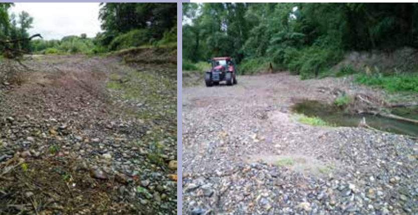
Vues avant travaux
