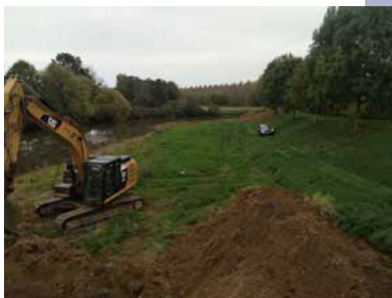
Arasement au-dessus du niveau moyen des eaux. Régalage des matériaux graveleux
