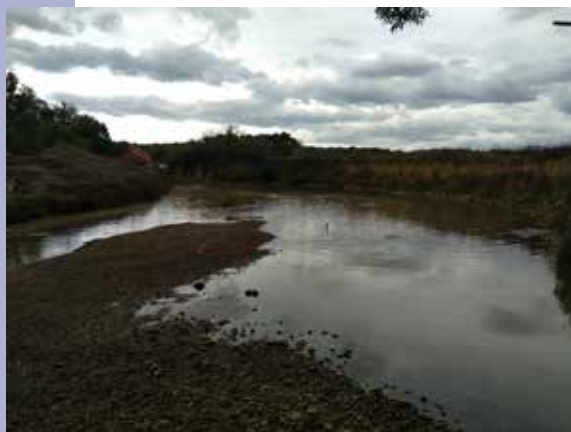
Erosion en amont d'un pont noyé communal
