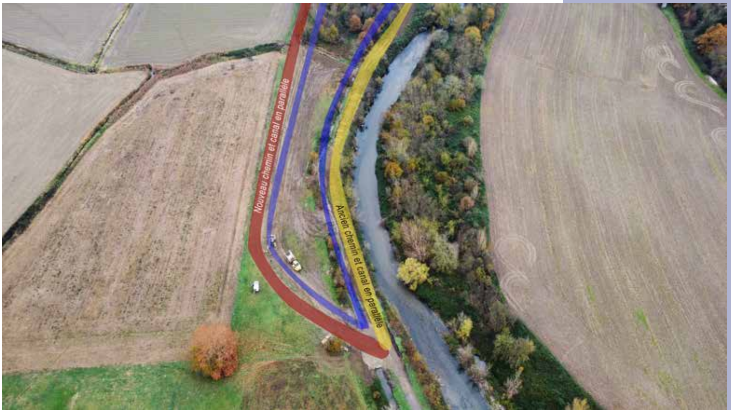
Déplacement du chemin Vic-en-Bigorre pendant les travaux
