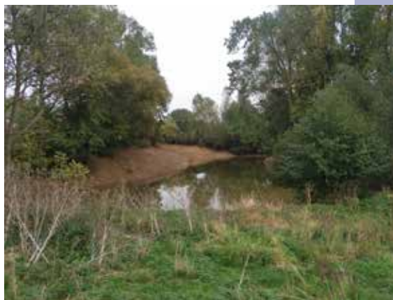
Mise en glacis de l'atterrissement et recentrage des écoulements. Végétalisation arbustive à venir
