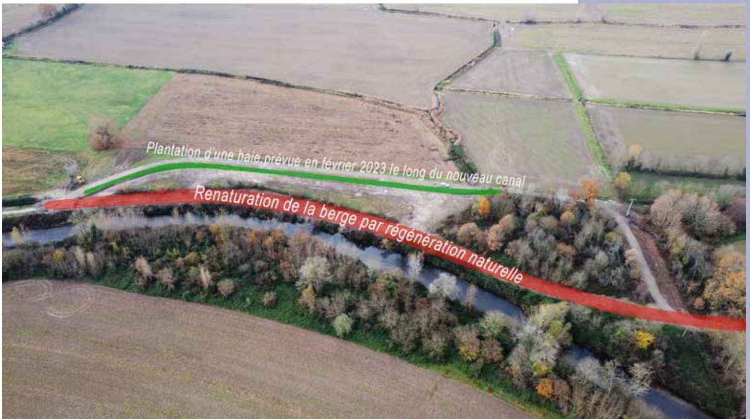
Déplacement du chemin Vic-en-Bigorre après les travaux
