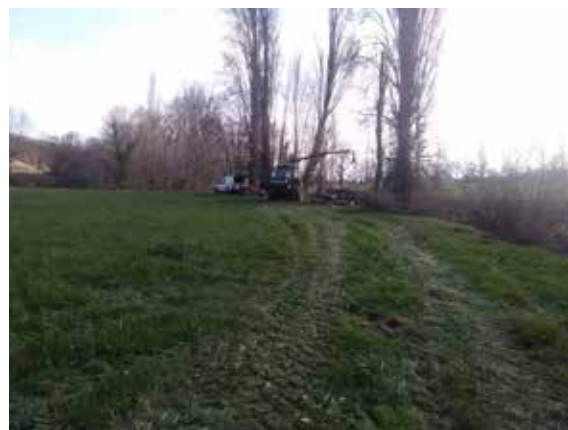
Abattage préventif en aval de St Sever de Rustan
