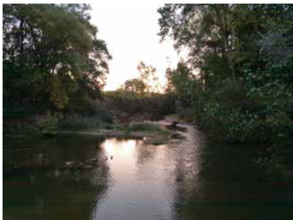
Erosion en amont d'une voirie avec risque de capture
