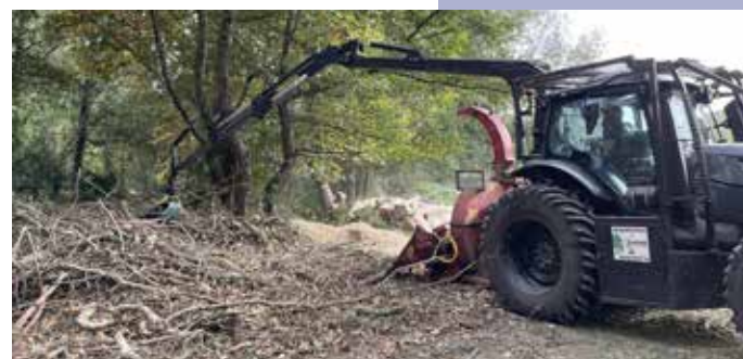
Broyage de rémanents à Arcizac-Adour (65)
