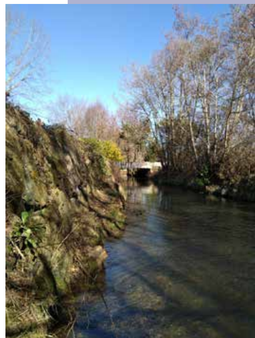
Situation après intervention
