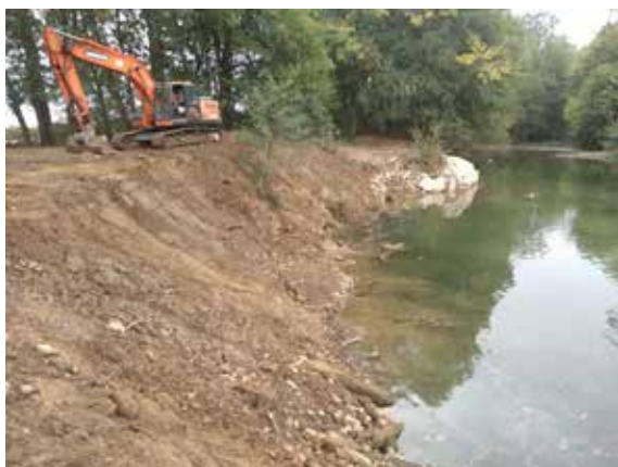
Démontage d'une partie de l'ancrage de la digue
