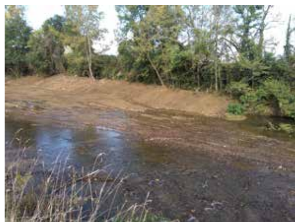
Broyage de la végétation et mise en glacis des galets. Végétalisation arbustive à suivre
