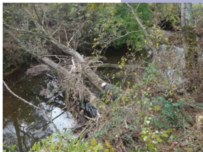
Travaux sur les Léés Réunis en amont de la station Vigicrue de Lannux
