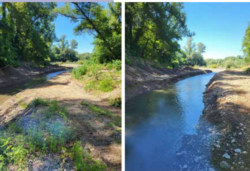
Vues après travaux
