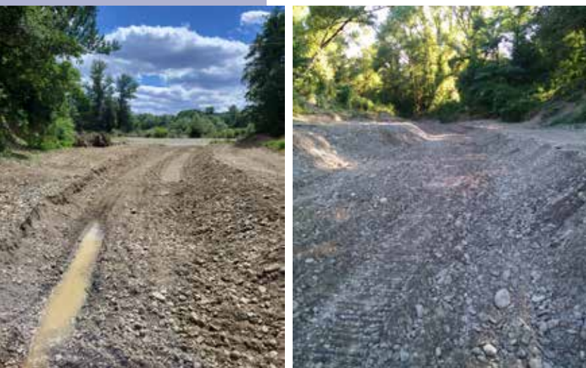
Vues pendant travaux
