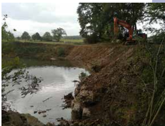
Talutage de berge avec végétalisation arbustive à venir
