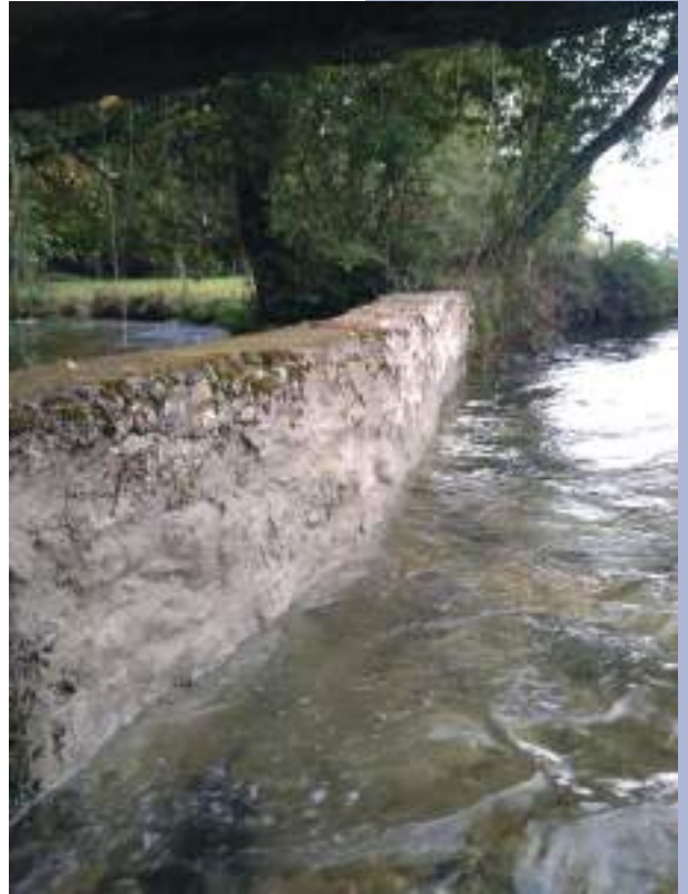
Réfection du muret
