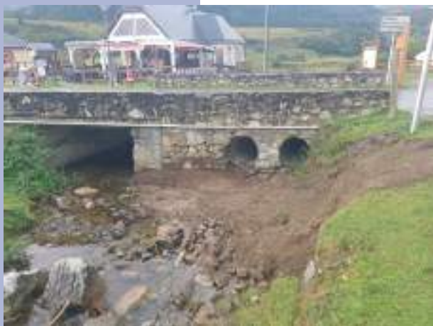
Vue amont du pont
