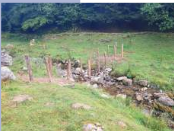
Installation du piège à embâcle
