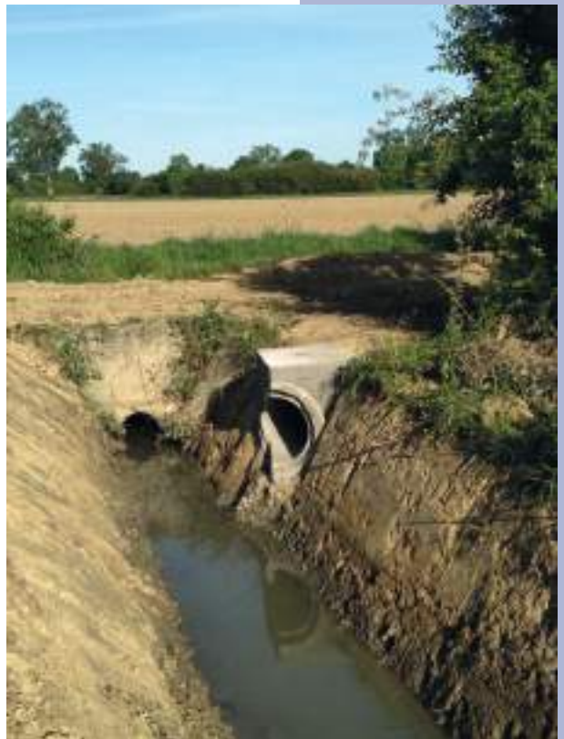
Doublement exutoire de l'ex Ayguevive
