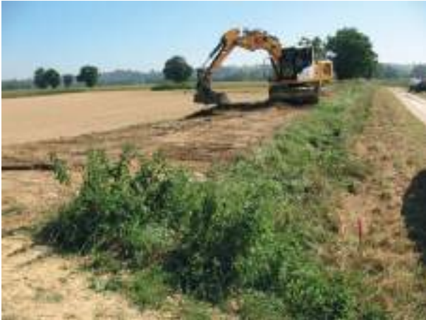
Arasement du merlon et mise en appui des matériaux pour accompagner la surverse
