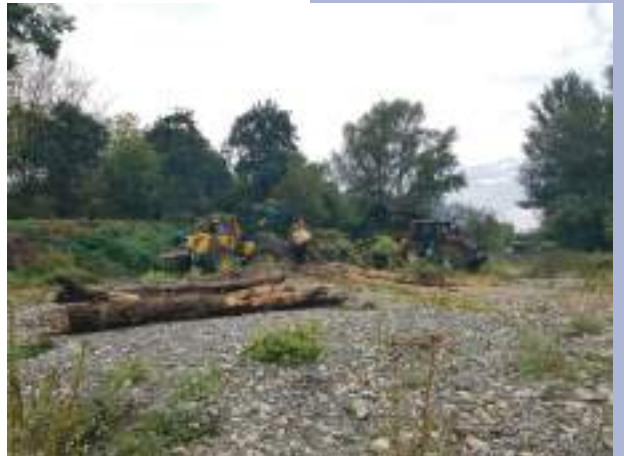
Traitement d'embâcle à Horgues
