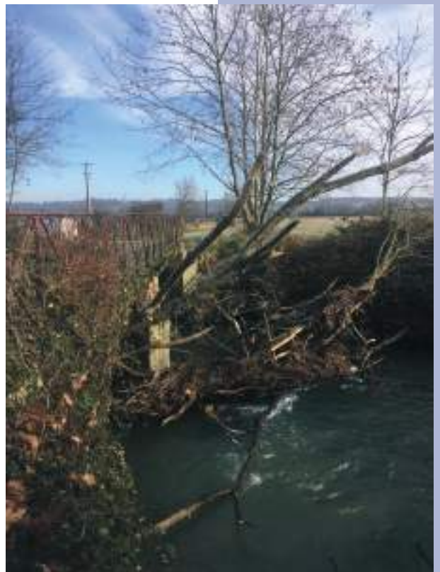
Pont «rouge» à Auriébat
