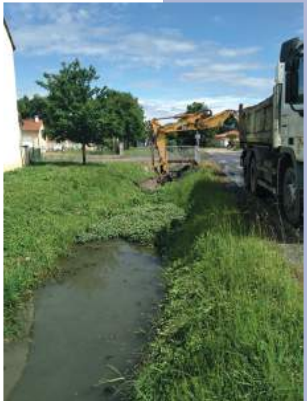
Nettoyage de l'ancien canal d'irrigation
