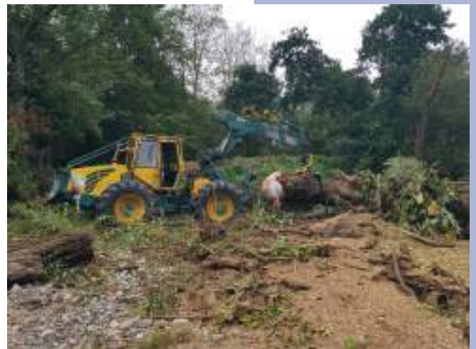
Pendant les travaux
