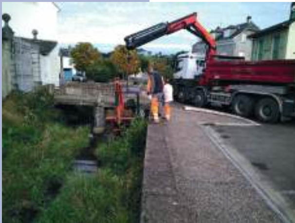
Par la suite une mini-pelle à pu réaliser les travaux en plusieurs étapes car différents ouvrages traversent le cours d'eau.
