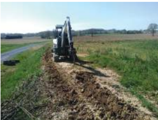
Réalisation des alignements pour la plantation avec dent de déroctage : limiter au maximum le travail du sol
