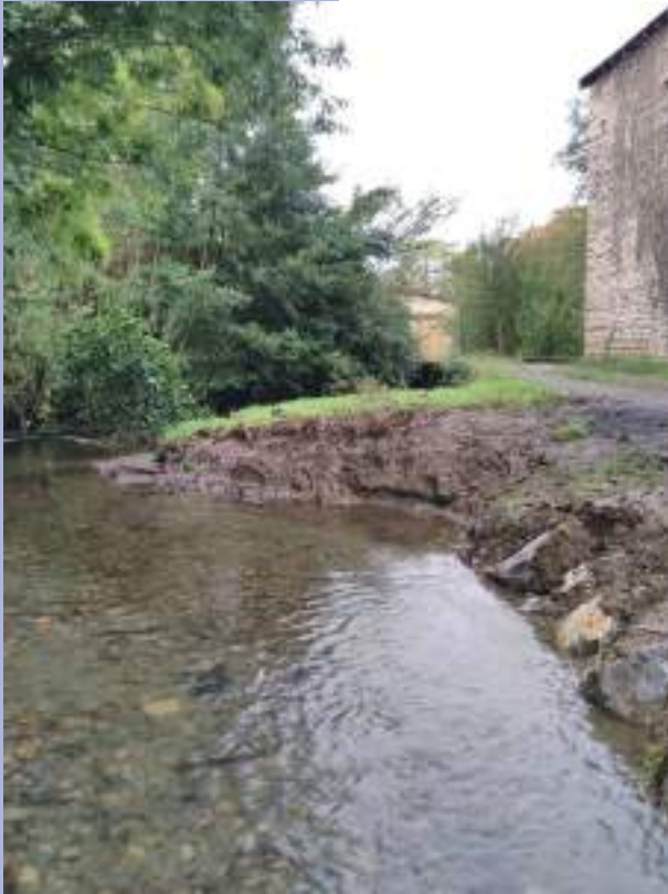
Avant le traitement de l'atterrissement en amont du pont de la RD2 à Orleix
