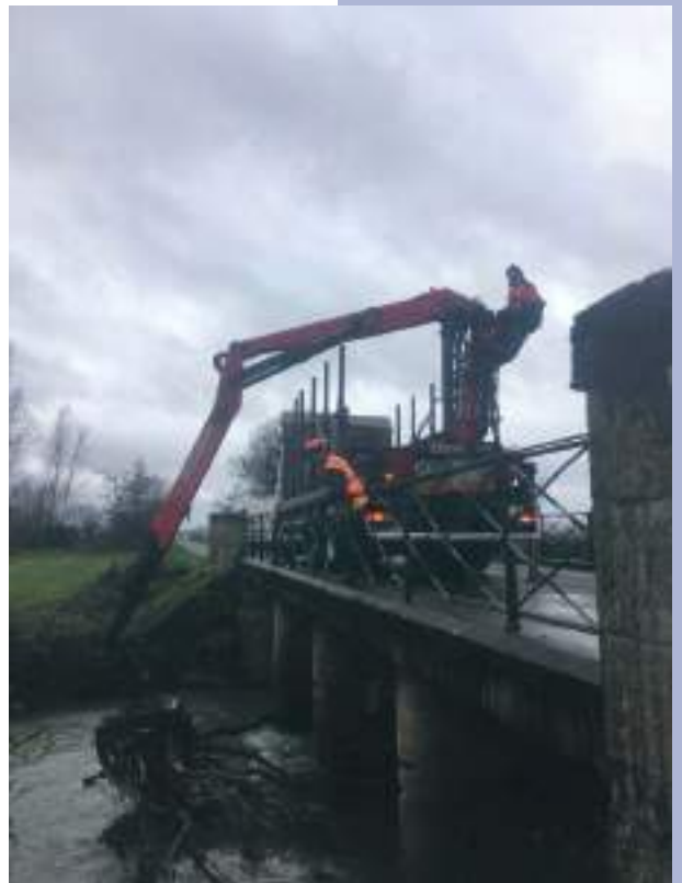
Dégagement du pont RD 52
