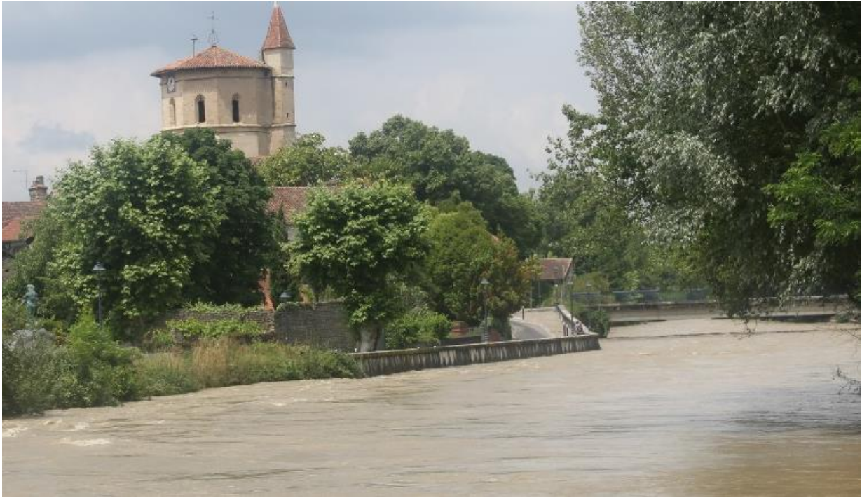
Crue de l'Adour proche la limite avant surverse de la digue de protection contre les inondations sur la commune de Maubourguet le 13 juin 2018 à 13h30
