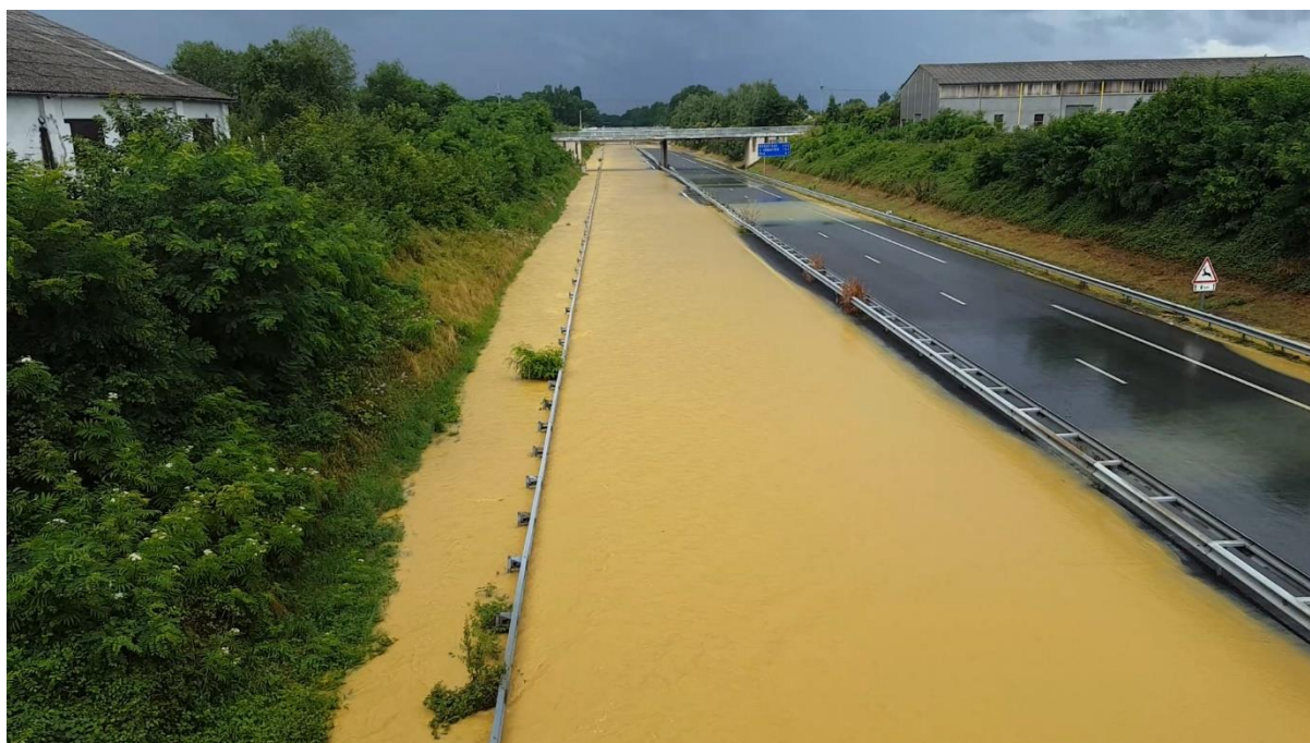
Photo des débordements du bras de décharge de l'Alaric sur l'A64 à proximité de la sortie de Tarbes Est lors de l'orage du 16 juillet au matin
