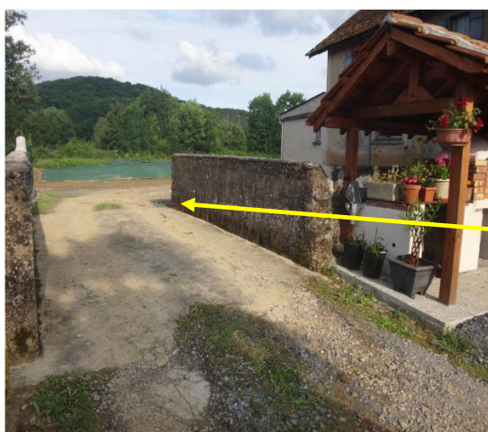
Photo du ponceau du moulin Bellegarde sur la commune de Lespielle
